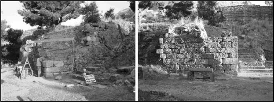
Resim 4 : Gıda Pazarı ile Athena Kutsal Alanı arasındaki duvarın köşesi. Çalışma esnasında ve sonrasındaki durum. Abbildung 4 : Mauerecke im Bereich des Vormarktes während und nach dem Wiederaufbau (A. Filges).
